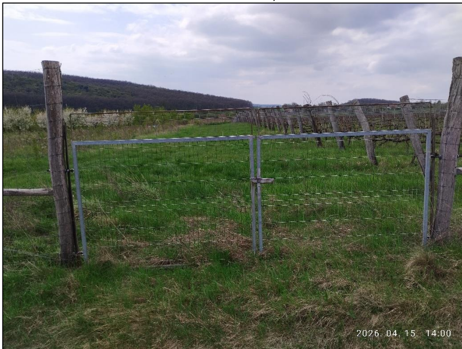
010/8 hrsz-ú önkormányzati tulajdonú közlekedési felület ingatlan nyitható vadvédő kapus bejárata (forrás: saját készítésű fotó)
